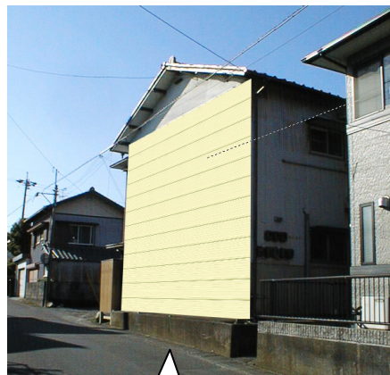
壁の張替え後
