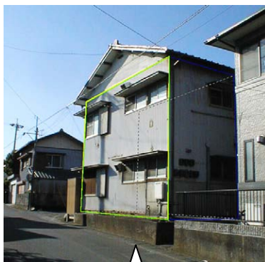
壁の張替え前
