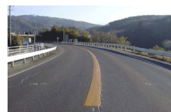
⑧ [着手前及び完成写真]
