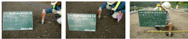
② [上層路盤工 粒度調整路盤工]
